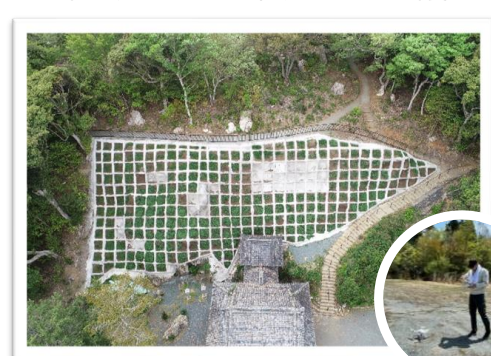
施工後 2022年4月 ドローン撮影
