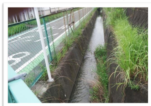
施工前 2020年7月 撮影
