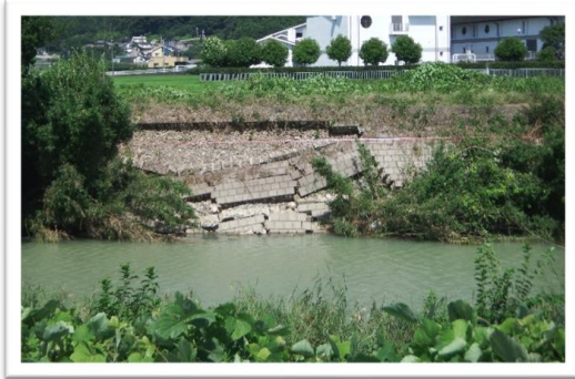
施工前 2022年7月 撮影
