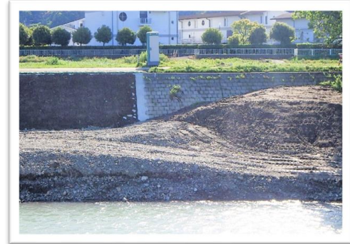
施工後 2023年4月 撮影
