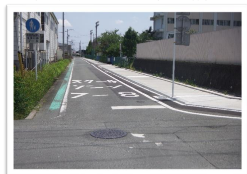
施工後 2022年6月 撮影
