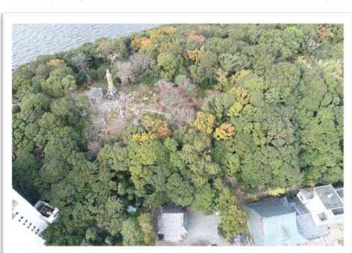
施工前 2020年12月 ドローン撮影
